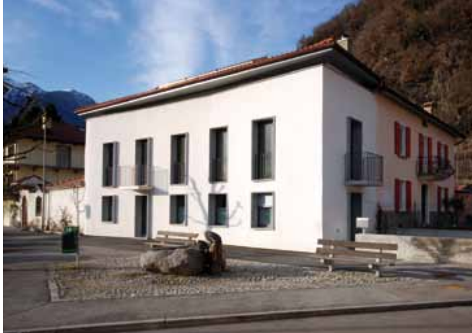
Edificio Minergie TI-277, casa monofamiliare rinnovata, Castione.
