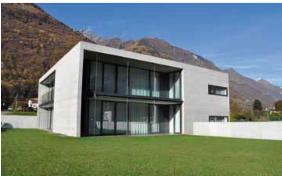
Edificio Minergie TI-179, nuova casa bifamiliare, Gnosca
