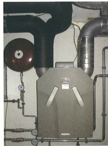
L'impianto per il ricambio d'aria automatico, la fa circolare recuperando il calore da quella aspirata dalla casa a quella fresca proveniente dall'esterno (foto sopra).
