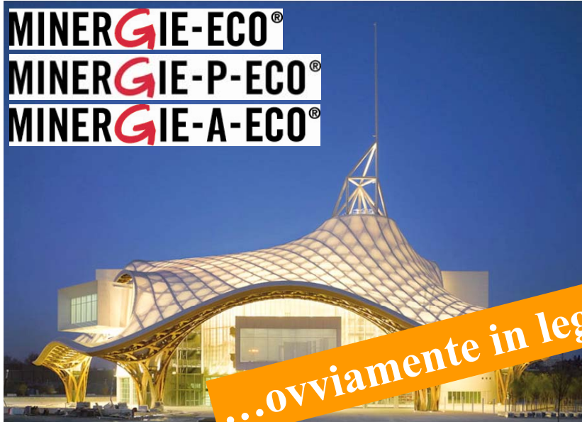
Centre Pompidou, Metz 2010
