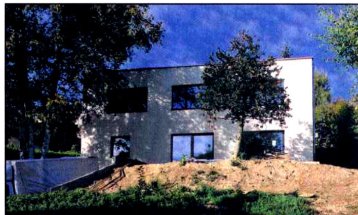
Après: rénovée, isolée et... agrandie, avec un toit plat. ALAIN WICHT
