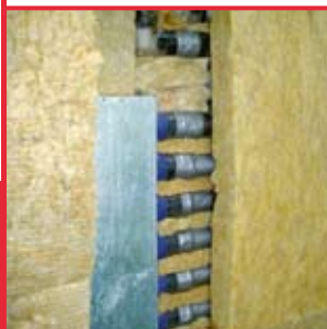
Conduit de distribution posé à l'intérieur de l'isolation
