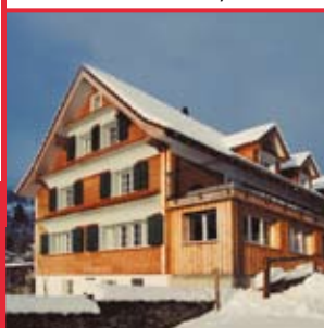
Maison individuelle historique modernisée à Amden, SG-141
