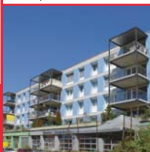
Immeuble collectif modernisé à Peseux, NE-100
