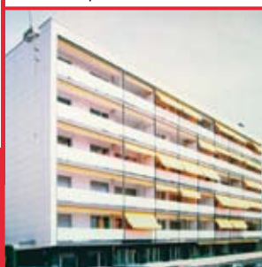
Immeuble collectif modernisé à Lausanne, VD-004
