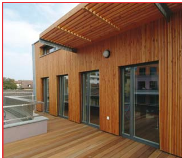
Les matériaux confèrent toute leur expression aux bâtiments.
