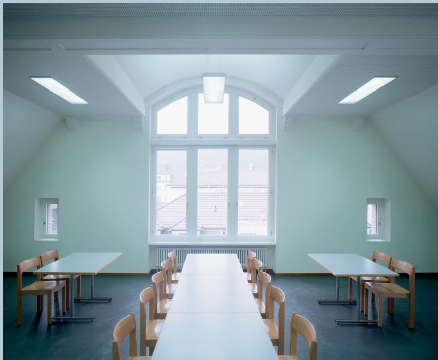
Combinaison de luminaires suspendus et encastrés à l'étage supérieur.
