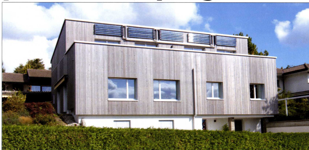
Première maison fribourgeoise rénovée, labellisée Minergie-P.
