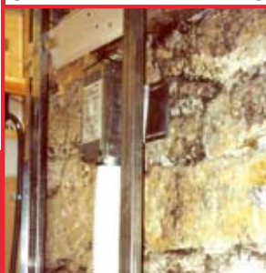
Verteilleitung und Durchlassgehäuse in der Innendämmung
