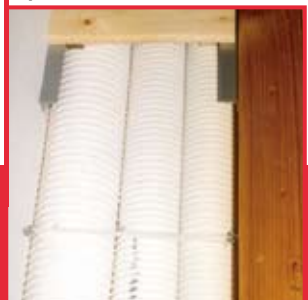
Verteilleitungen zwischen Sparren
