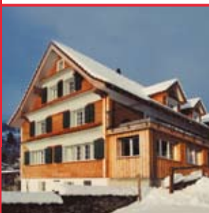
Modernisiertes historisches Einfamilienhaus, Amden, SG-141
