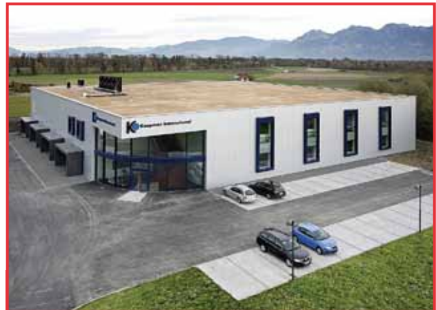
Dank frühzeitiger Ausrichtung auf das Ziel Minergie-P wurde das Bauprojekt der Koopman International zur Erfolgsgeschichte.
