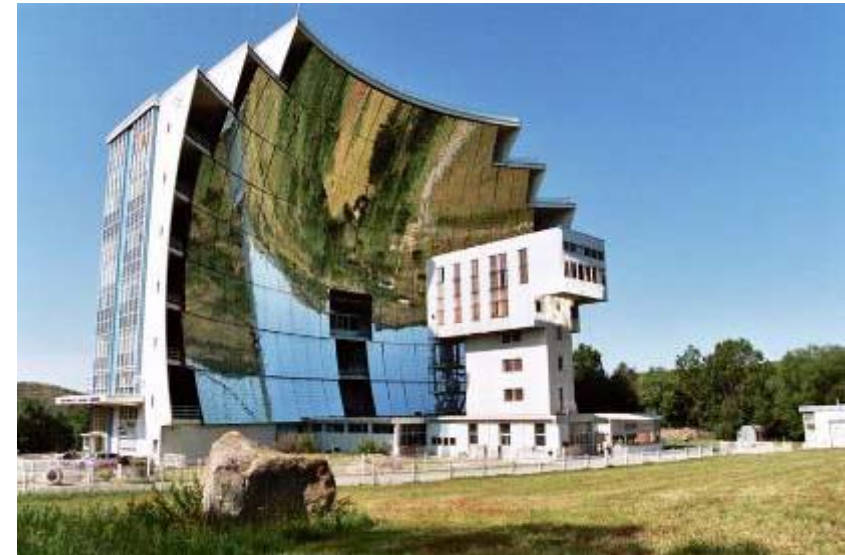
1100 kW, 4000 °C Solarschmelzofen Odeillo, Spanien
