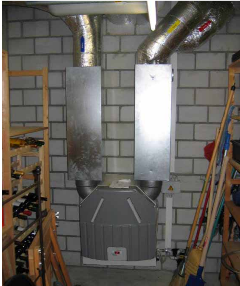
Luftungsgerät
