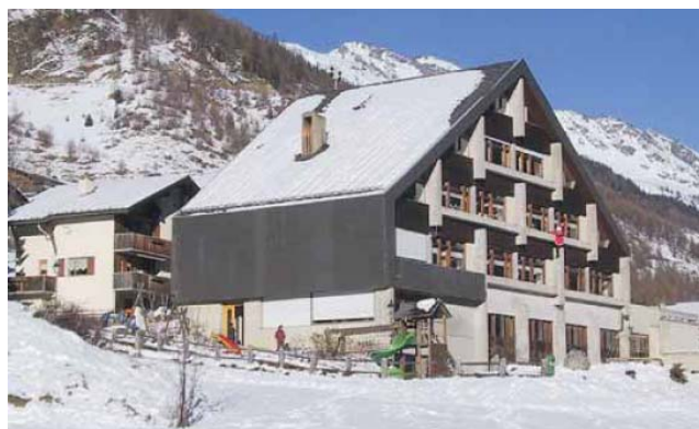
VS-191 Sanierung Schulhaus Wiler
