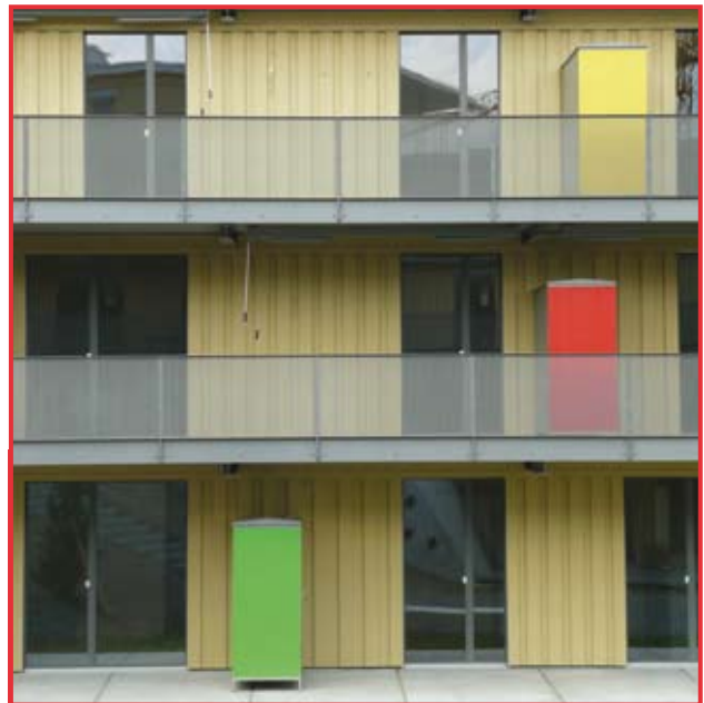
Holzfassaden bringen bauliche und ökologische Vorteile. (Foto: Egli Rohr Partner AG)
