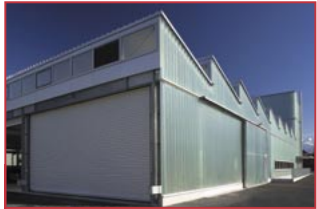
Industriehalle mit Sheddach.
