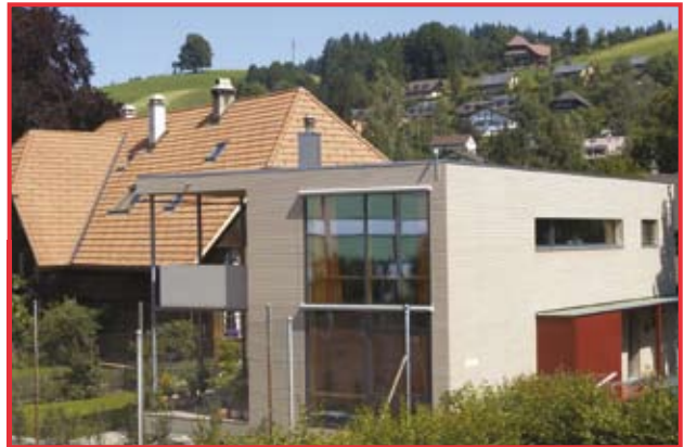
Blick aus Südosten: Aus städtebaulichen Gründen konnte nur die Schmalseite des Hauses gegen Süden ausgerichtet werden.
