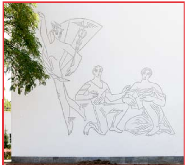
Die Nordfassade wurde auf der Innenseite gedämmt.
