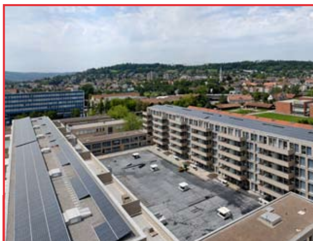
Die Solarzellen auf dem Dach des Eulachhofs liefern 80 Prozent des Stroms für die Wärmepumpen. (Foto: Allreal, Nick Brändli)
