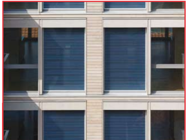
Wie die Fensterflächen ermöglicht die transparente Wärmedämmung passive Solargewinne. (Foto: Heiko Hellwig)
