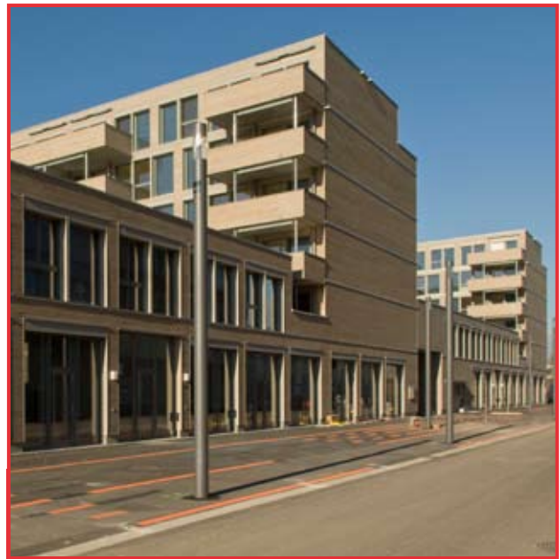
Die gemischte Bauweise in Holz gibt dem Eulachhof seine starke Ausdrucksweise. (Foto: Allreal, Alex Wydler)
