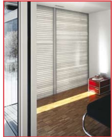
Die undurchsichtigen Solargläser vor den Schlafräumen speichern das Sonnenlicht und geben es zeitverzögert nach innen ab.
