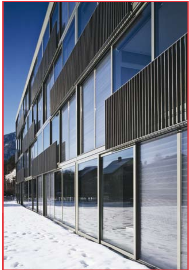
Grosszügige, nach Süden ausgerichtete Fenster bringen viel Tageslicht ins Innere der Wohnungen.
