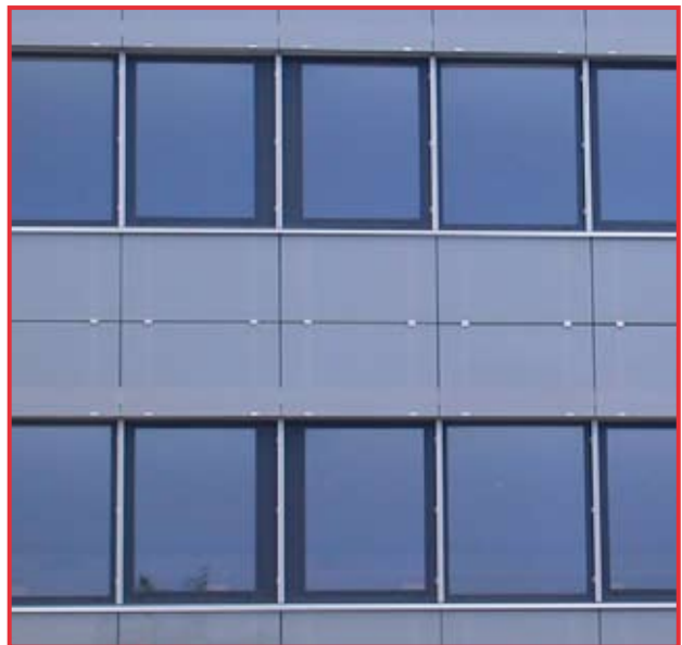
Die hinterlüftete Glasfassade sorgt für optimalen Sonnen- und Wetterschutz
