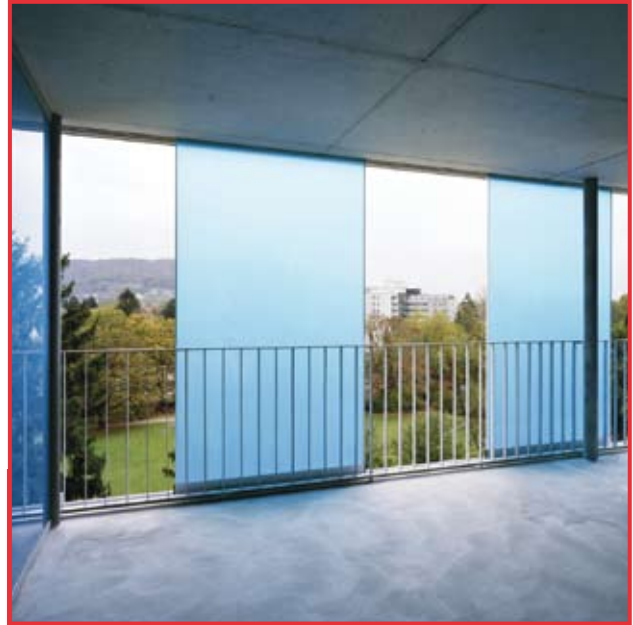
Die Schiebeelemente bieten auch den Bewohnern Gestaltungsraum.
