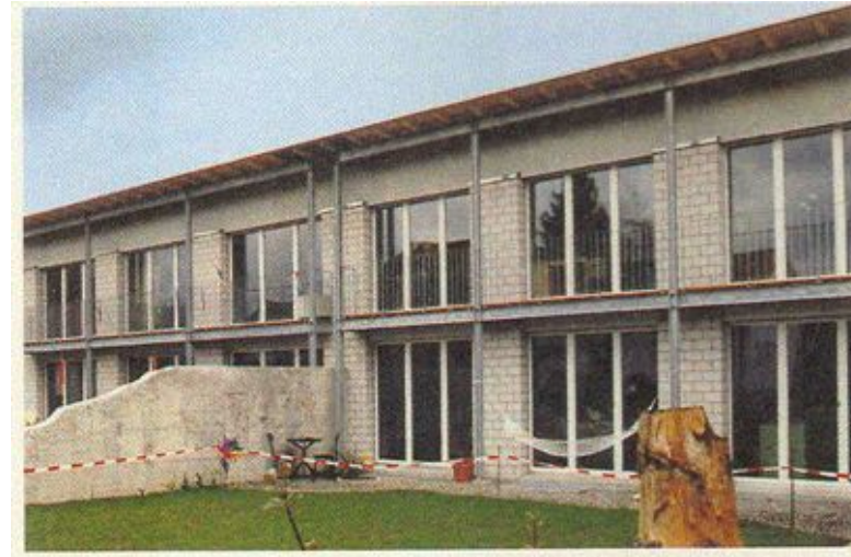
AG-004, 1994 Haus Tardent/Wullschleger, Kölliken: Kompakte, hochgedämmte Hülle, mit Gas- und Holzofen
