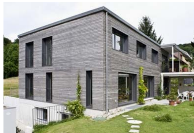
Einfamilienhaus, Holzbau, Minergie P
